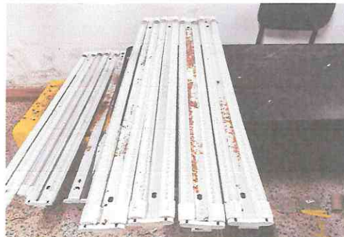
Imagen correspondiente al estado de las lámparas que se cambiaron en el Establecimiento.
