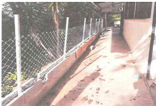
Imagen corresponde al proceso y avance del muro perimetral frontal del Establecimiento.
