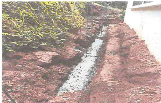
Imagen correspondiente al cemento del muro perimetral.
