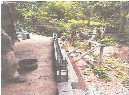
Imagen corresponde a los cimientos e inicios del muro perimetral frontal del establecimiento.
